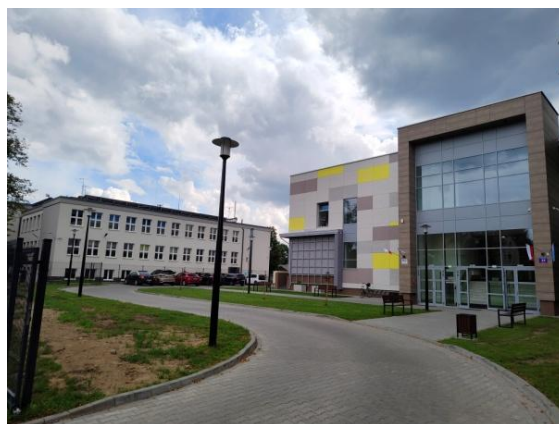
Fot. 2. Miejska pływalnia i Zespół Szkół Ponadpodstawowych (sierpień 2025) Źródło: Opracowanie własne
